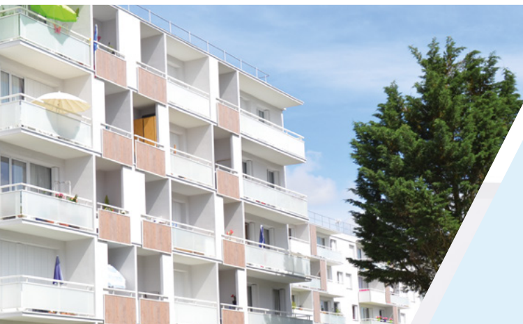
ESSONNE HABITAT Rue de l'Aunette - Ballancourt Architecte Lelli Architectes
