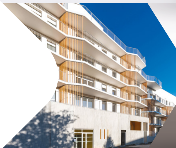
TERRALIA Résidence Les Balcons d'Hélios - Noisiel
